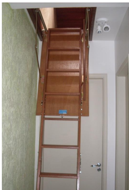
Figura 57 -Alçapão para Acesso a Cobertura
