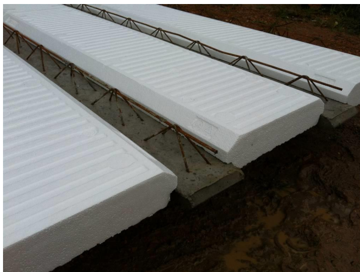
figura 48 - Vigotas pré-moldadas com EPS.
